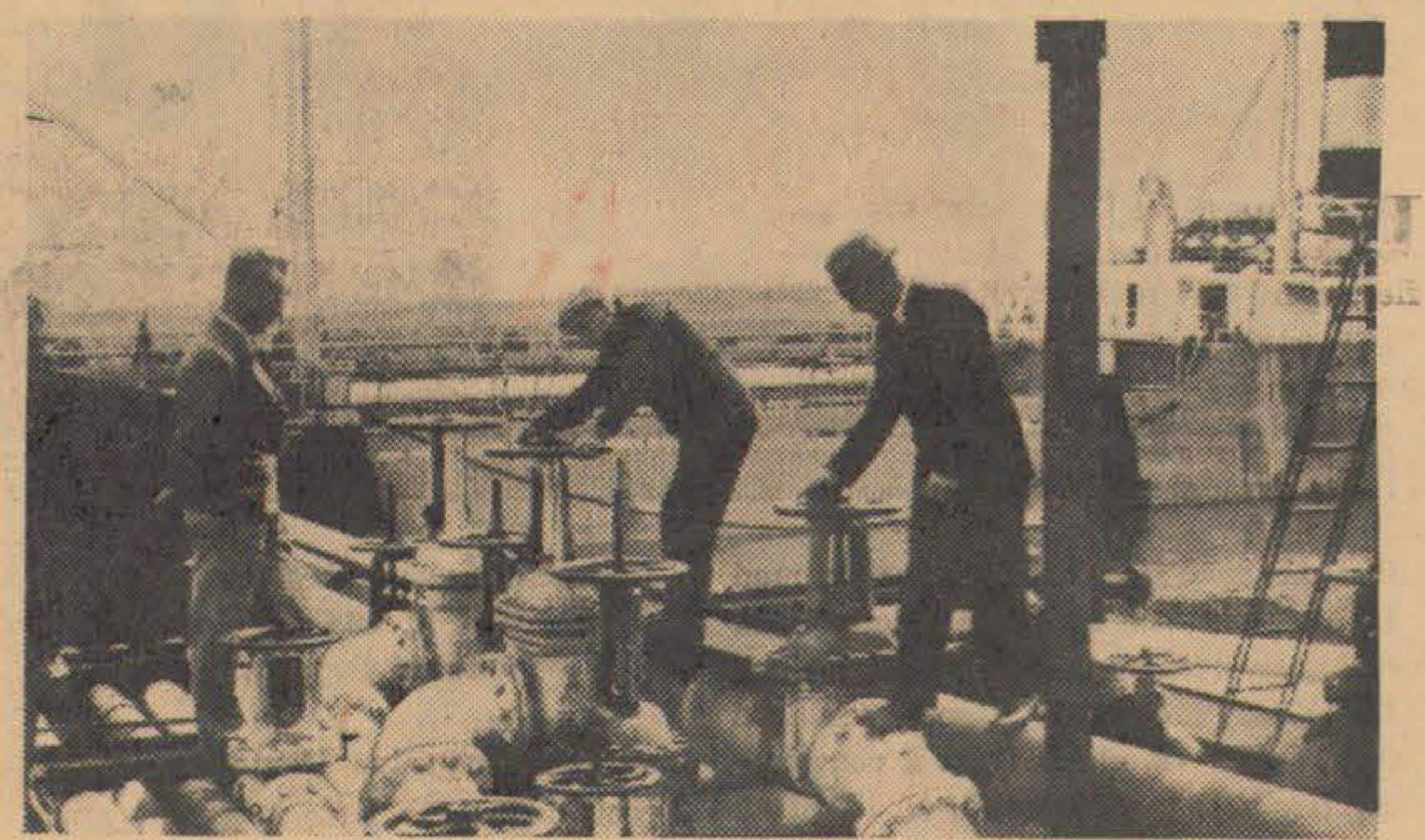
Genom ett invecklat rörsystem pumpas oljan ombord på tankångaren.
